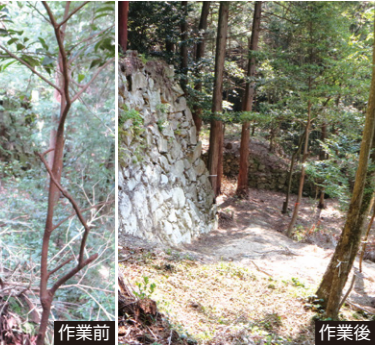
作業前には見えなかった石垣が現れる
