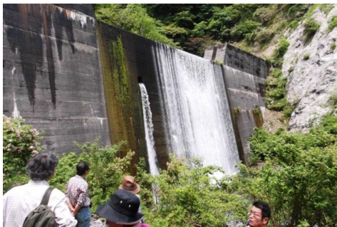
百瀬川最上部砂防ダム
